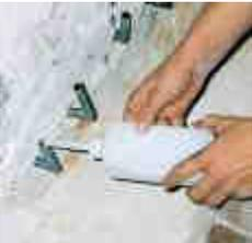
Abb. 10: Wässern der Kapillarstäbchen über die Kartuschenwinkel
