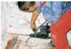
Abb 8: Setzen der horizontalen Bohrungen
