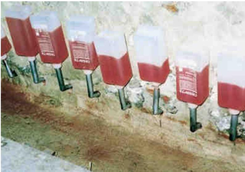
Injektion nach dem Kartuschenwinkel-Verfahren
