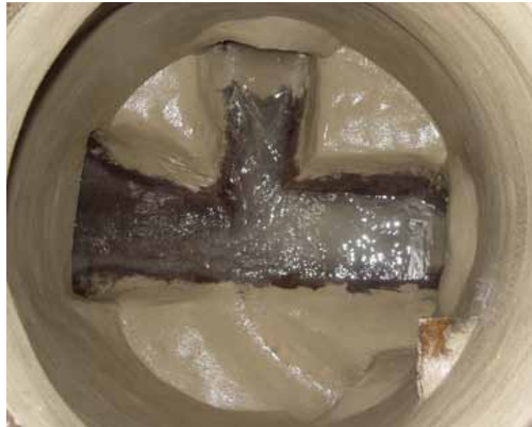
Mit KÖSTER Schachtmörtel geschützter Abwasserkanal mit dazugehörigem Schacht
